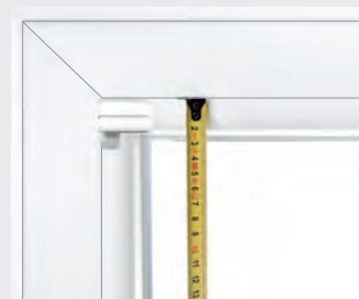
Empfohlener Messpunkt: Glasleistenfuge
