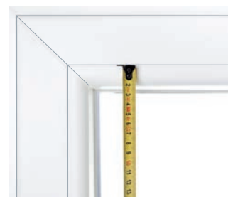
Empfohlener Messpunkt: Glasleistenfuge
