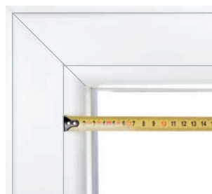
Empfohlener Messpunkt: Glasleistenfuge ggf. auf Beschläge achten
