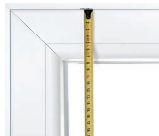
Fertige Höhe: Empfohlener Messpunkt: Ende Fensterflügel
