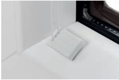
konisch schräge Glasleiste
