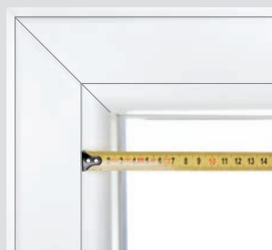
Empfohlener Messpunkt: Glasleistenfuge ggf. auf Beschläge achten
