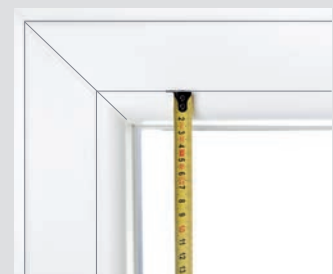
Empfohlener Messpunkt: Glasleistenfuge
