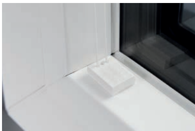
gerade, eckige Glasleiste (Tiefe 20mm) mit Spanschuh
